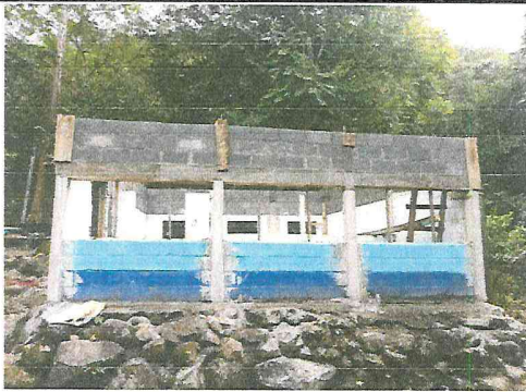
Foto 3: Levantado de hileras del block en aula de Preprimaria
