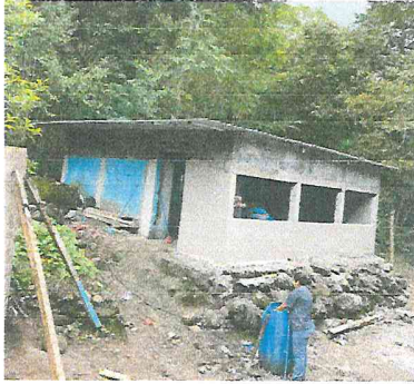
Foto 1: Aplicación de monocapa en Paredes del aula de Primaria
