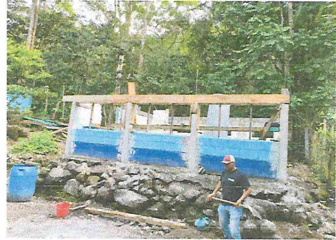
Foto 2: Refuerzo de Pilares de hierro y concreto en aula de Preprimaria
