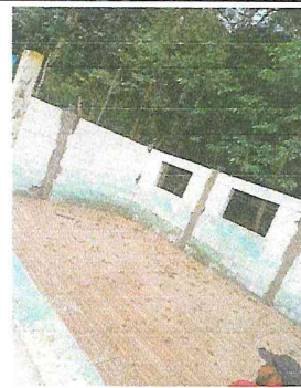
Foto 4: Instalación de piso cerámico en aula de Preprimaria
